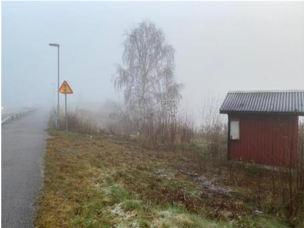
Figur 6. Avloppspumpstation Sjötången. Foto platsbesök 2020-11-27.
